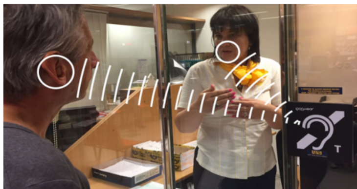
Slika 22: okence z vgrajeno indukcijsko zanko in slika 23: Prenosna indukcijska zanka
