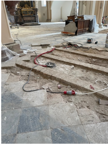
Vgradnja indukcijske zanke v cerkvi Porta Coeli v Tišnovu
