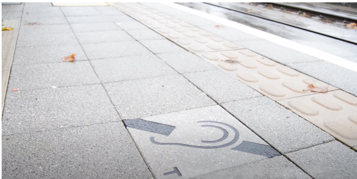
Slika 14: Oznaka nameščene IL zanke na ploščadi v obliki betonske ploščice v Nottinghamu
