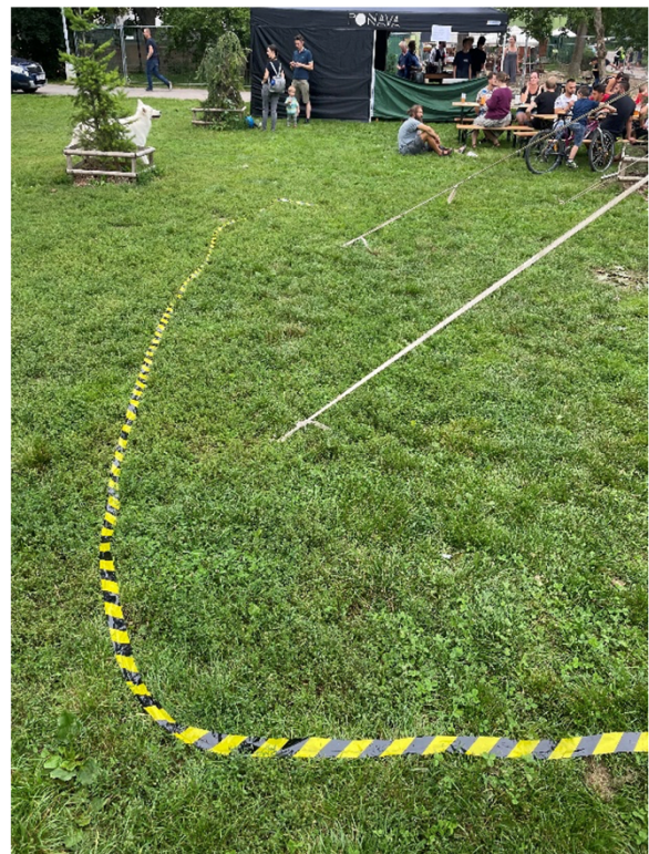
Prikaz priprave in vključevanje indukcijske zanke v Avditorij v Pragi
