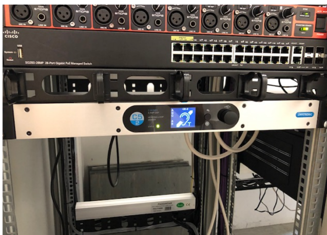
Ojačevalec indukcijske zanke Merjenje signala
