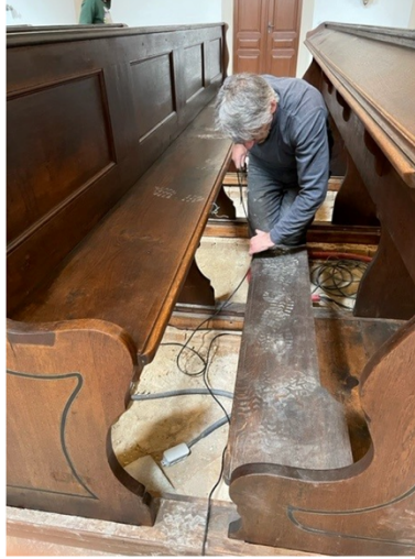
Vgradnja indukcijske zanke v cerkvi Porta Coeli v Tišnovu
